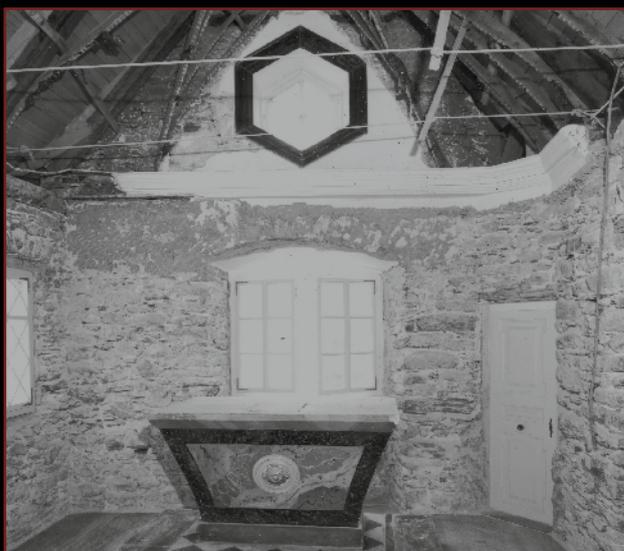
Nachdem das Gewölbe bereits herausgeschlagen war, fand die Bauarchäologie bei der Renovation von 1973/74 auf der Höhe des Kranzgesimses ein Brett, das in der Nut eines Balkens eingeschlagen war. Daraus schloss man auf eine Flachdecke, welche die Renovation denn auch realisierte. Damit zerstörte man die Sakralität des Gotteshauses weitgehend. Den sechseckigen Okulus hat man durch eine Serliana ersetzt.
